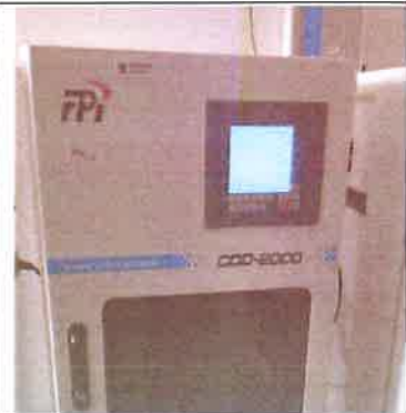
3. 总排口 COD 监测设备
